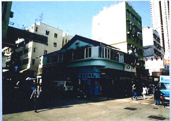
斜型屋頂，難以安裝消防水缸
